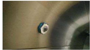
La sonde de cantonnement peut également agir sur la mise en veille en dessous d'une certaine température et mise en route automatique du système, au-dessus d'une certaine température (fonction non activée par défaut)
