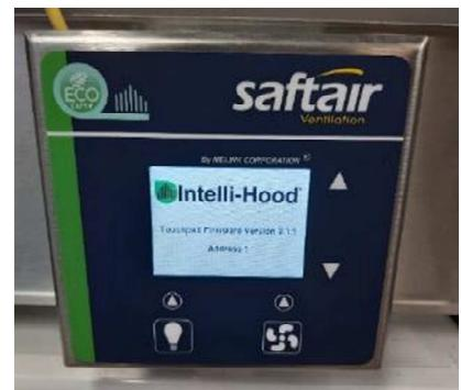
Il est préférable de le raccorder directement au système d'exploitation au moins pour la phase de mise en service afin d'éviter les problèmes d'interconnexion (plus le nombre de connections entre l'écran tactile et le système d'exploitation sont nombreuses, plus le risque de disfonctionnement de l'écran tactile est important).
