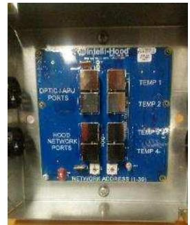
Il fait office de multiprise et doit être installé en dehors du flux d'air. Il peut être installé au-dessus de la hotte, mais pas dans la hotte.
