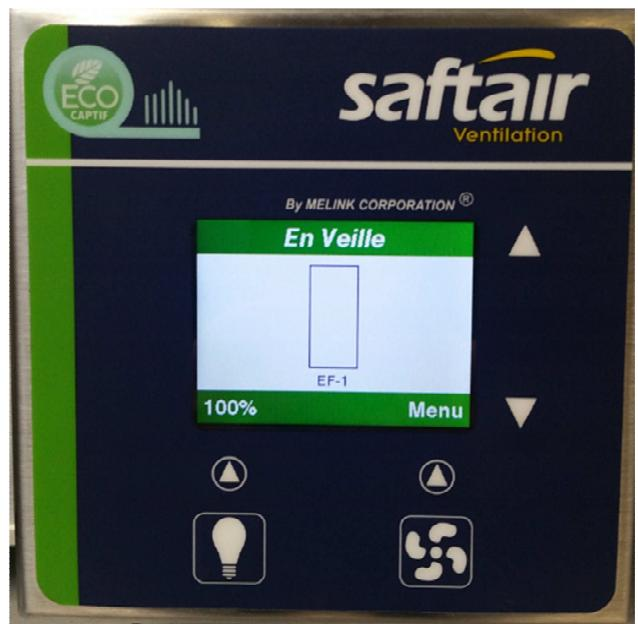
Pour le contrôle des éléments du système, il faut utiliser le Menu : « 1.Statut », puis le sous-menu « 3. Contrôleurs de hotte ».
